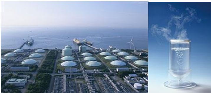
LNG 基地と LNG
