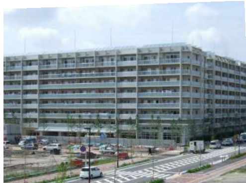
住棟セントラル暖房給湯システム
