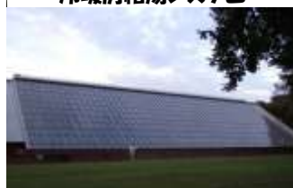
プール加熱(冷暖房給湯)
