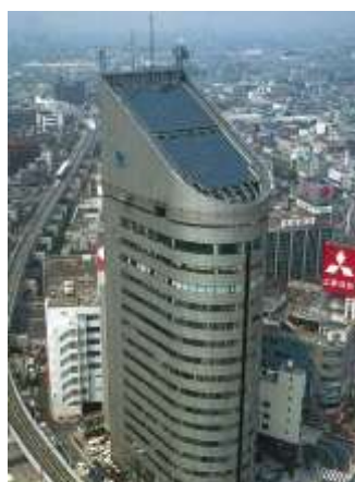
冷暖房給湯システム
