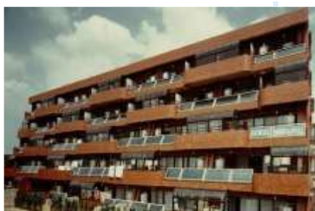
バルコニー設置給湯システム
