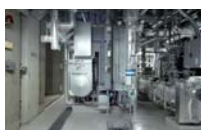
蒸気焚きソーラージェネリンク
