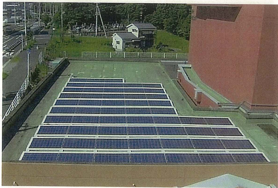
A館 研修棟 屋上
