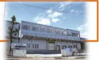
超低温冷蔵保管庫
