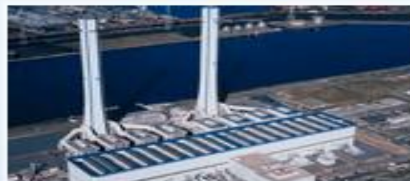
ガスタービン複合発電プラント (GTCC)
