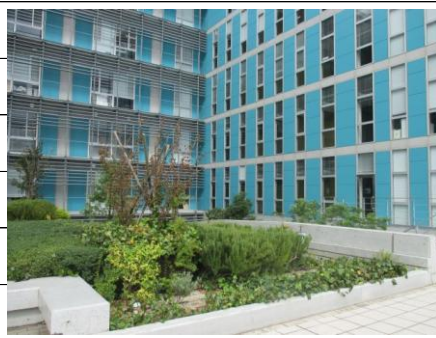
中庭(屋上緑化にも)
