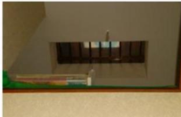
屋根裏部屋の床面開口部と天窓 を階段下からの吹き抜け 状況を見上げた状態
