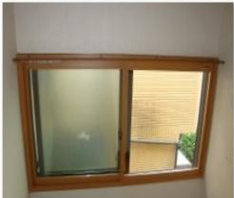
階段途中の内窓(後) (1.8 × 1.0m)
