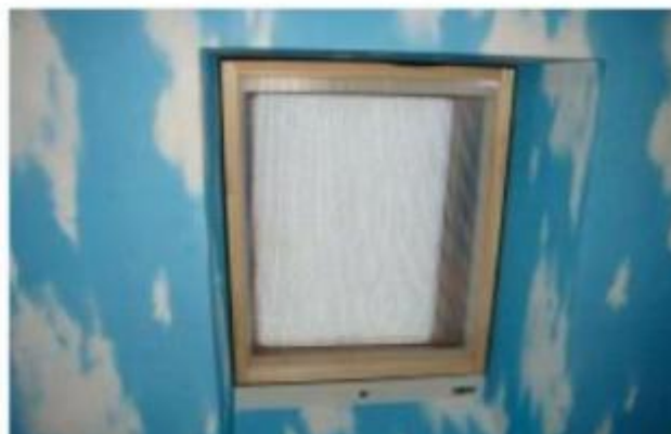
屋根裏部屋の天窓内窓付き の状態
