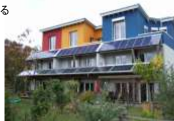
庇に設置した集熱器
