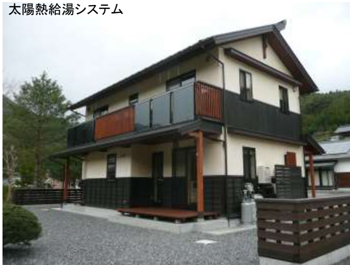
バルコニーに集熱器(6m 2 )を設置、蓄熱槽は300ℓ
