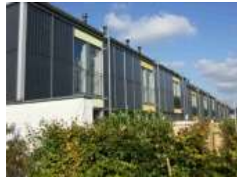
壁面設置の集熱器
