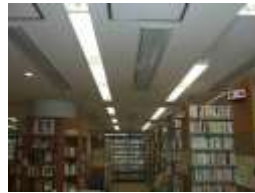
室内のチルドビーム空調機
