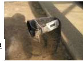
地中からの 戻りダクト
