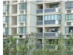
バルコニー設置
