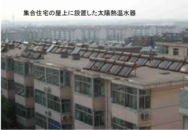
屋上に設置したソーラーシステム
