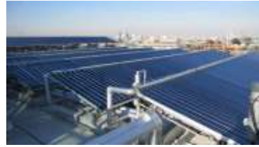
真空管形太陽集熱器: 170㎡
