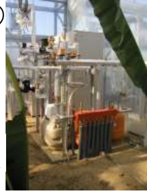
地下水熱源 ヒートポンプ
