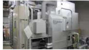
吸収式冷凍機: 411kW
