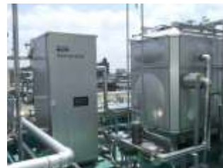
温水焚吸収式冷温水機35.2kWと 蓄熱槽2.2m 3
