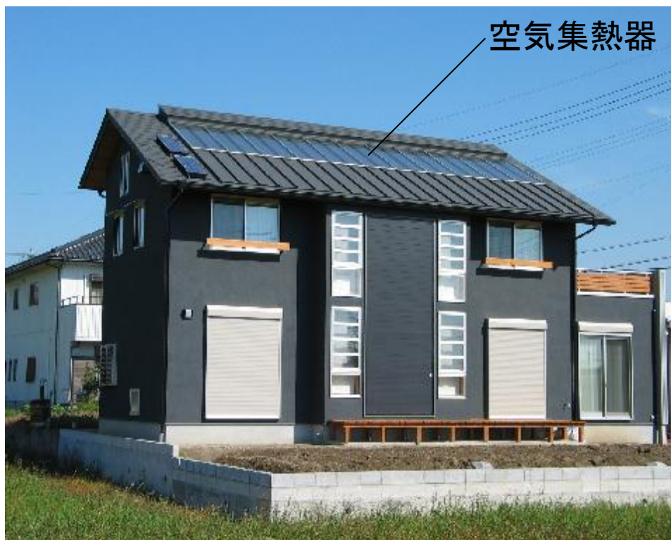
屋根に空気集熱器、南壁面中央に空気集熱面
