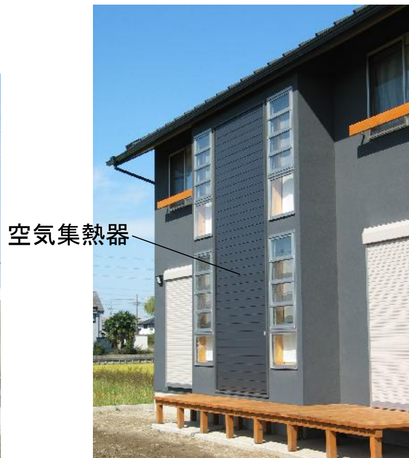
南壁面のガラス無し空気集熱面
