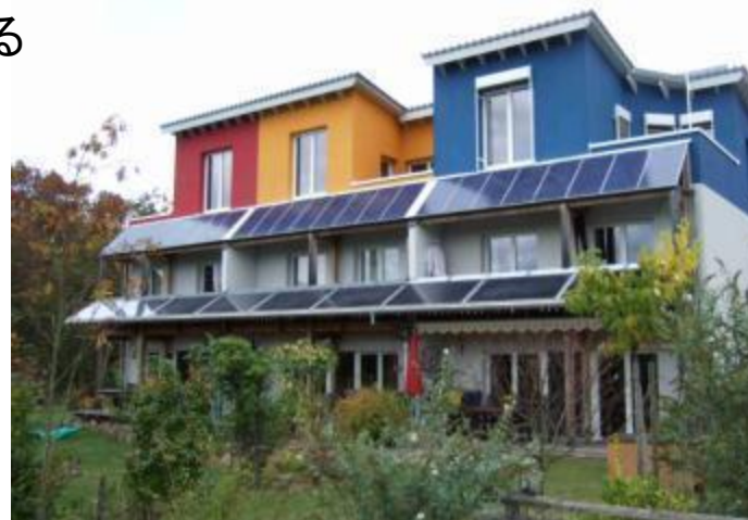
庇に設置した集熱器
