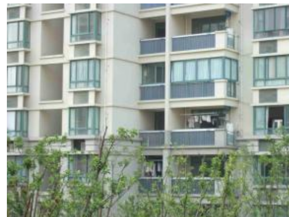
バルコニー設置
