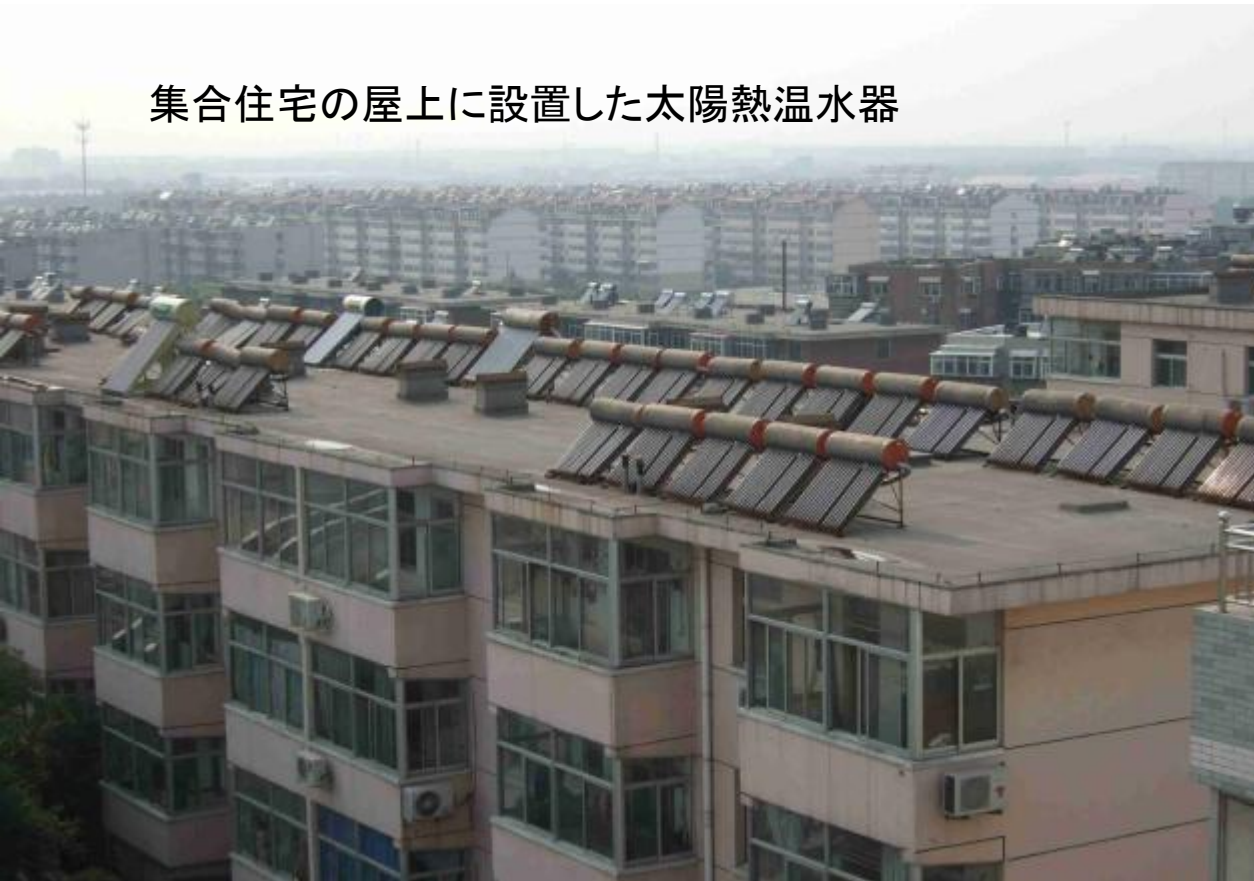
屋上に設置したソーラーシステム
