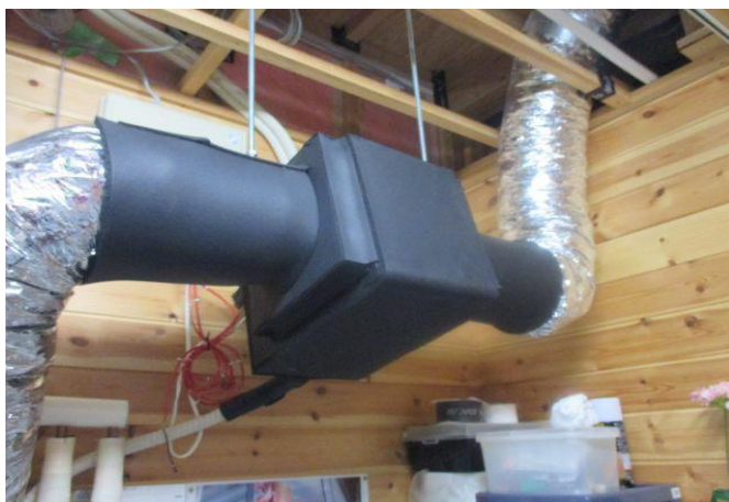
高性能顕熱型第1種換気システム「Focus200(熱交換効率93%)」(ドイツ製)とチラー(冷却器)。この組合せで室温を一定に保つ。
