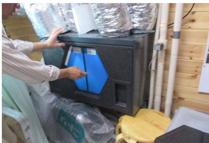
高性能顕熱型第1種換気システム「Focus200(熱交換効率93%)」(ドイツ製)とチラー(冷却器)。この組合せで室温を一定に保つ。
