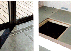
左：床下に吹き込まれた空調管の放射熱を伝へ、右：十分な歩行を妨げず、メンテナンススペースを確保して使用。
