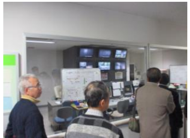
(中央監視センターでは、安定運転に神経を注いでいる。灯油使用量も監視している)
