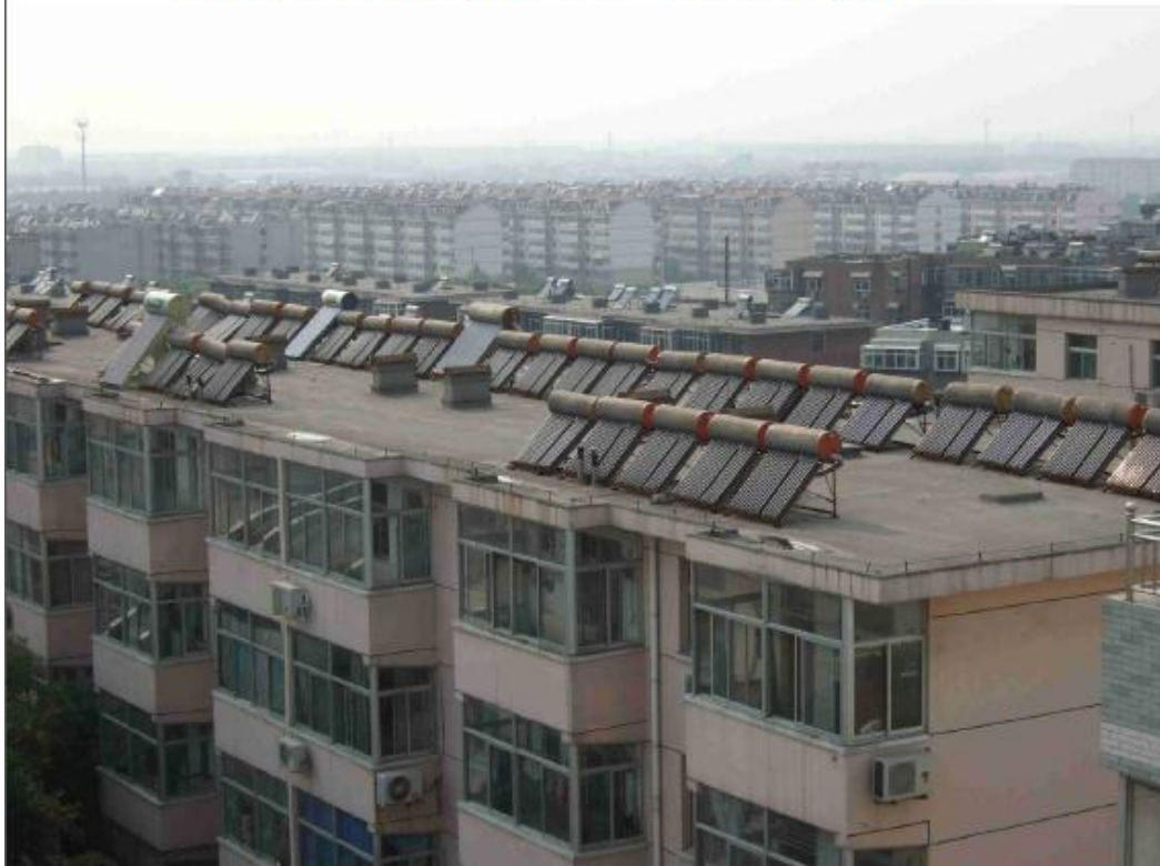
屋上に設置したソーラーシステム
