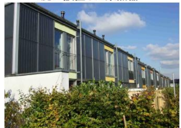
壁面設置の集熱器
