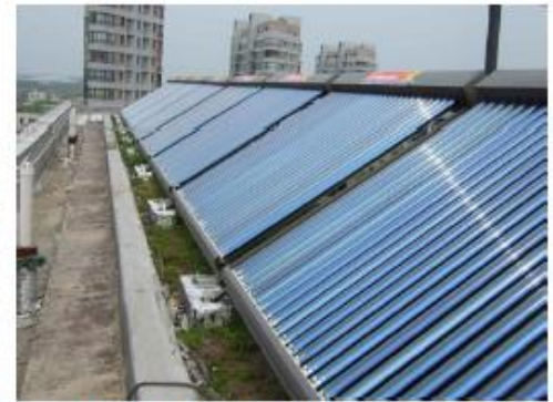
屋上に設置したソーラーシステム
